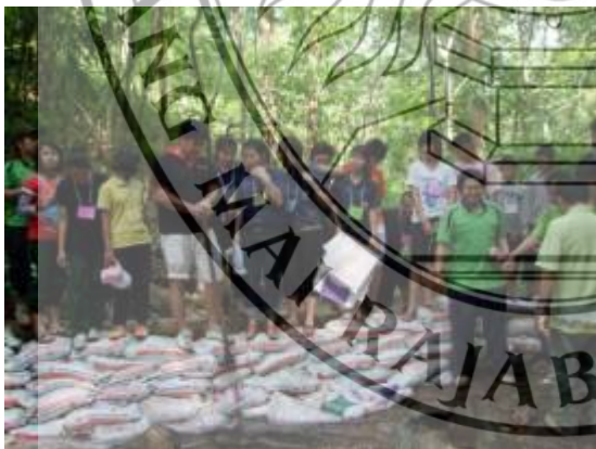
ภาพที่ 4.9 การทำฝายชะลอน้ำและตะกอนและปลูกหญ้าแฝกเพื่อลดการพังทลายของดิน
