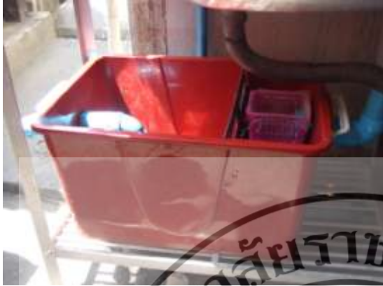
ภาพที่ 4.8 แสดงถึงถังไขมันที่ติดตั้งและวัสดุอุปกรณ์ที่ใช้ทำถังไขมัน
