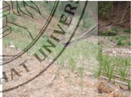
ภาพที่ 4.9 การทำฝายชะลอน้ำและตะกอนและปลูกหญ้าแฝกเพื่อลดการพังทลายของดิน
