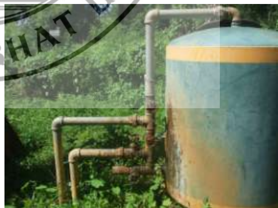
ภาพที่ 4.34 แสดงถังพักน้ำและถังกรองน้ำสำหรับอุปโภคบริโภคหมู่บ้านห้วยบง
