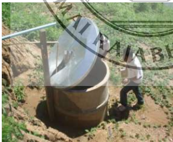
ภาพที่ 4.7 แสดงน้ำบ่อน้ำตื้นและระบบกรองน้ำที่ใช้ในพื้นที่บ้านน้ำดิบ
