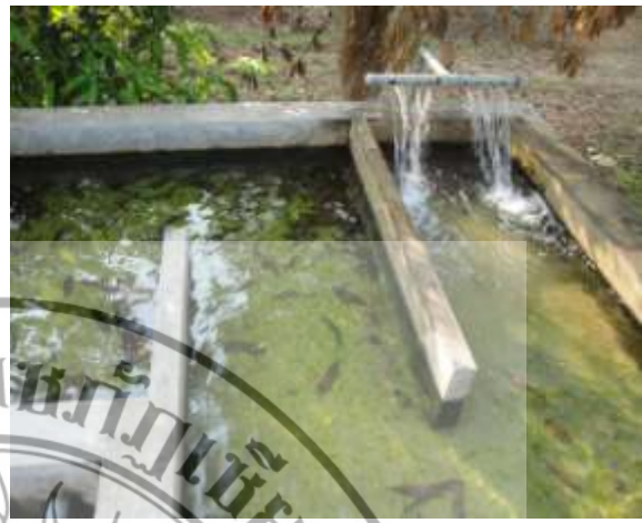
ภาพที่ 4.28 แสดงบ่อสูบน้ำดิบและบ่อเติมอากาศของระบบผลิตน้ำอุปโภคบริโภคบ้านแม่กองแป
