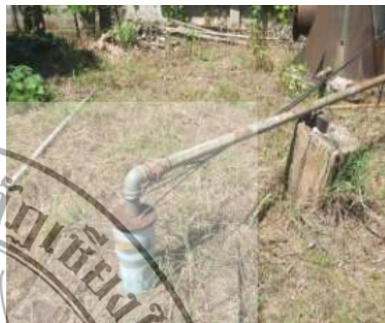
ภาพที่ 4.8 แสดงถังพักน้ำและป้อนน้ำบาดาลในพื้นที่บ้านน้ำดิบ
