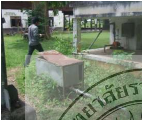
ภาพที่ 4.28 แสดงบ่อสูบน้ำดิบและบ่อเติมอากาศของระบบผลิตน้ำอุปโภคบริโภคบ้านแม่กองแป
