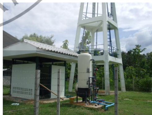
ภาพที่ 4.4 ภาพแสดงการปรับปรุงระบบประปาหมู่บ้าน
