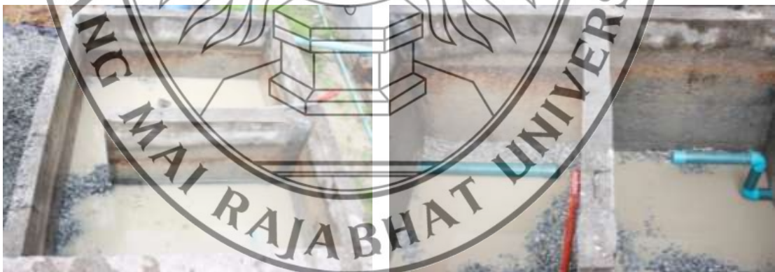
ภาพที่ 4.7 แสดงภาพถ่ายของระบบบึงประดิษฐ์ที่ใช้ในการวิจัย
