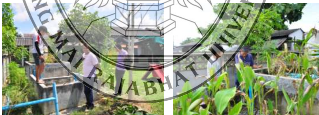
ภาพที่ 3.7 แสดงการดำเนินการวิจัยบำบัดน้ำเสียจากการผลิตกระดาษสาโดยบึงประดิษฐ์
