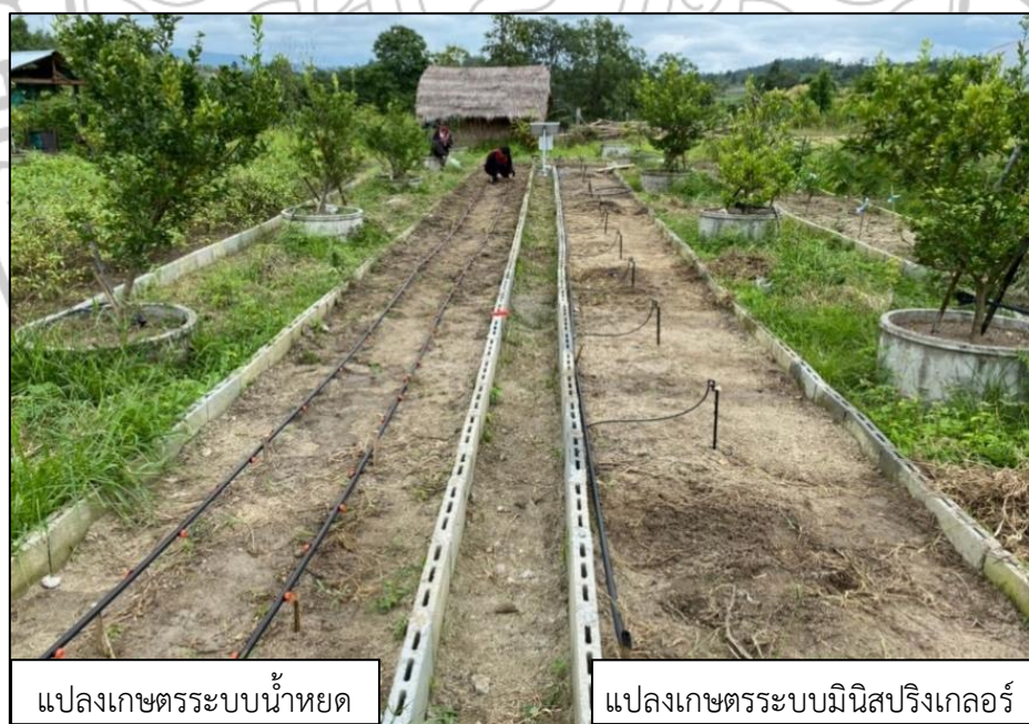
ภาพที่ 4.7 การติดตั้งระบบระบบจ่ายน้ำอัจฉริยะ แบบระบบสปริงเกอร์ และระบบน้ำหยด
