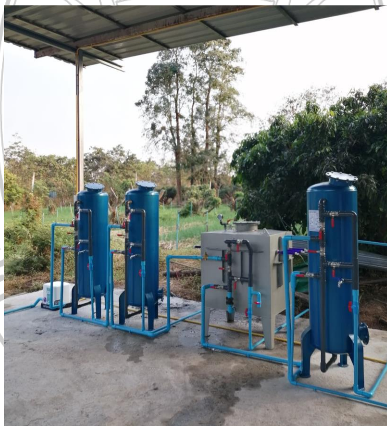
ภาพที่ 4.39 ต้นแบบระบบบำบัดน้ำบาดาลเพื่อการบริโภค
