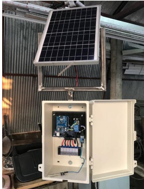
รูปที่ 4 การติดตั้งระบบ IOT และทดสอบการทำงานของระบบ
