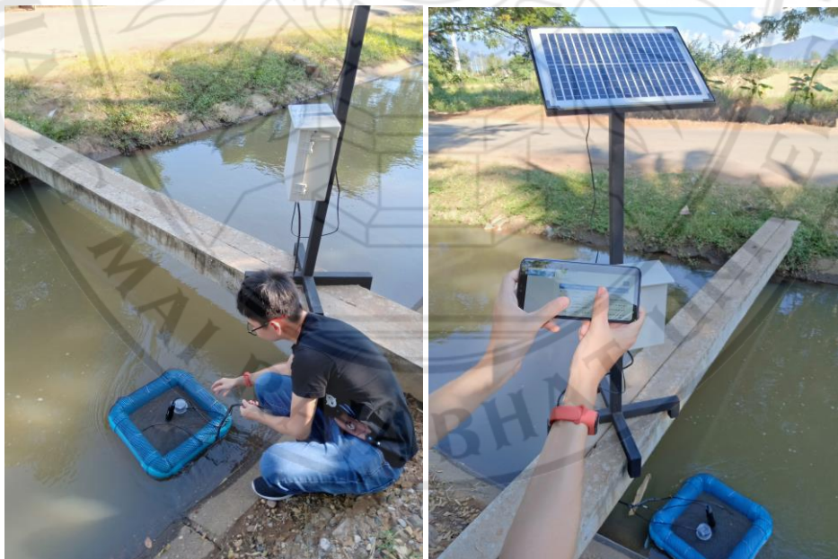
ภาพที่ 3.15 แสดงการทดลองใช้ และการติดตั้งเทคโนโลยีเซนเซอร์ตรวจวัดคุณภาพน้ำ
