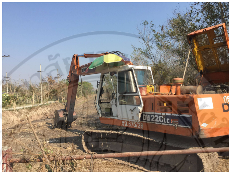
ภาพที่ 4.8 การขุดลอกลำเหมืองเจ้าสีหมื่น ที่มา : ถ่ายภาพโดย ชุติทธิ์ ชูชาติ
