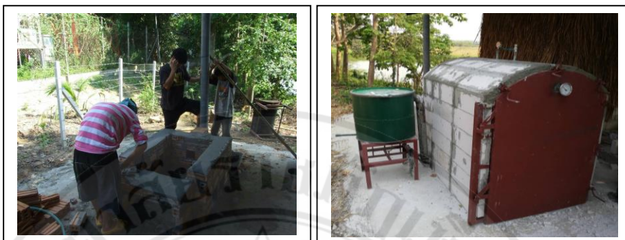
รูปที่ 4.13 แสดงการดำเนินกิจกรรมการปรับปรุงเตาต้มฟางสำหรับผลิตเชื้อเพลิงแก๊สชีวภาพของชุมชน
