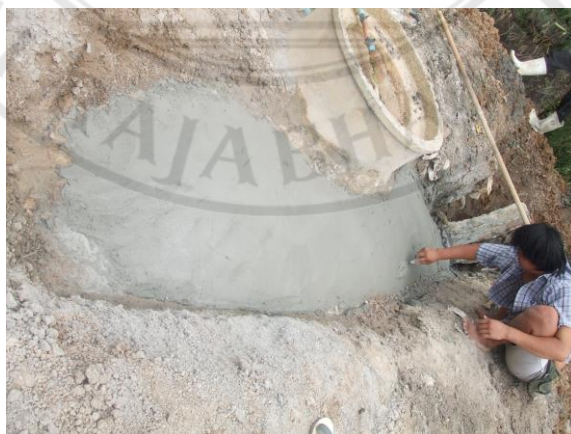
ภาพที่ 4.10 แสดงภาพก่อนและหลังการปรับปรุงบ่อก๊าซชีวภาพในส่วนบ่อหมักก๊าซชีวภาพ
