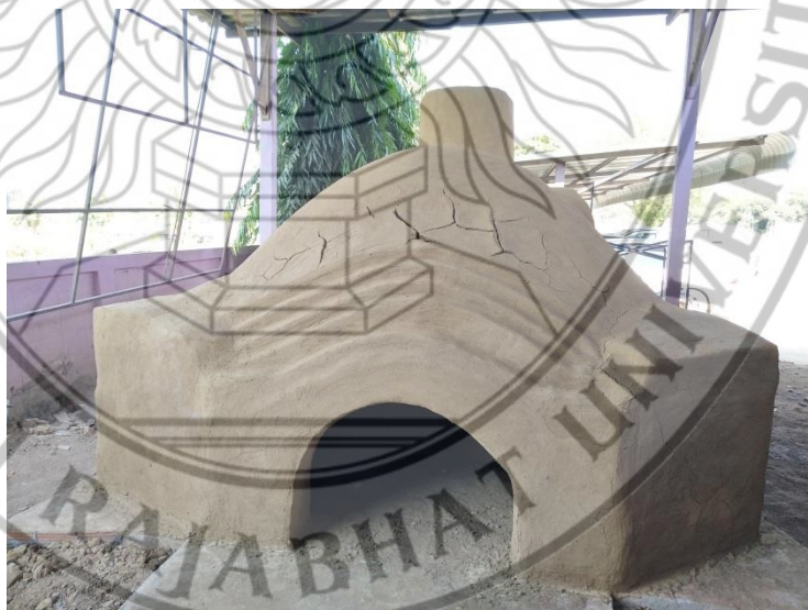
ภาพที่ 4.30 ลักษณะและองค์ประกอบของเตาฟืน
