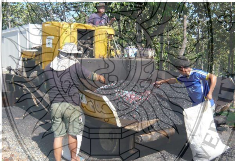
รูปที่ 4.11 การผสมขยะถุงพลาสติกในเครื่องจักรปูถนน
