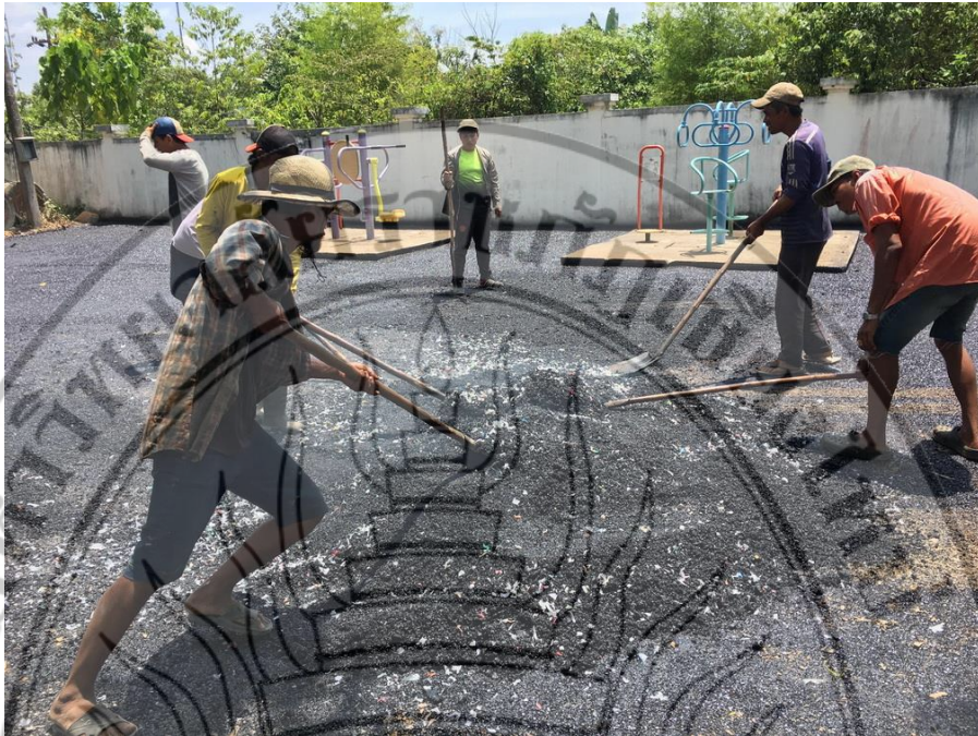
รูปที่ 4.12 การผสมขยะถุงพลาสติกด้วยแรงงานคน
