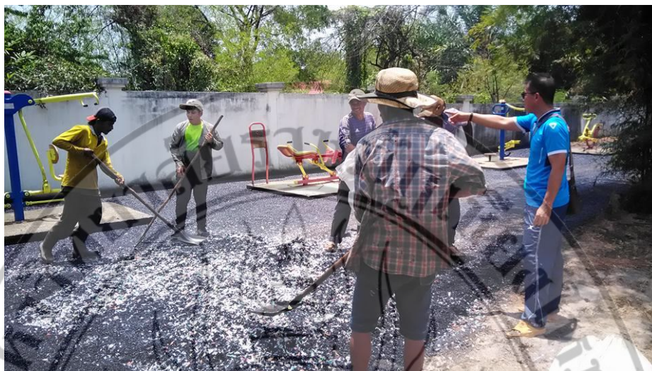
รูปที่ 3.21 นำพาราแอสฟัลต์คอนกรีตผสมขยะถุงพลาสติกปูทับบนชั้นPrime Coat
