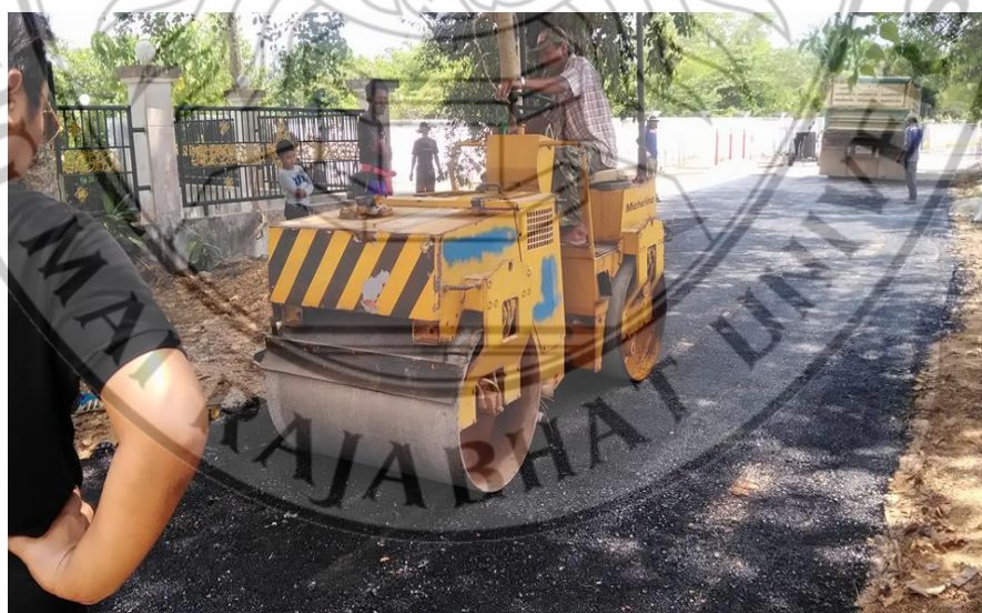
รูปที่ 3.22 บดทับชั้นพาราแอสฟัลต์คอนกรีตผสมขยะถุงพลาสติก
