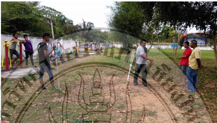
รูปที่ 3.19 การก่อสร้างชั้นพื้นทาง ปรับระดับ รองผิวทาง
