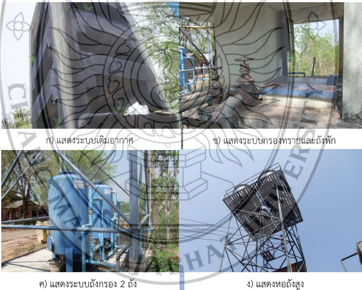
ภาพที่ 4.3 แสดงระบบผลิตน้ำอุปโภคบริโภคในหมู่บ้านหนองบัว
